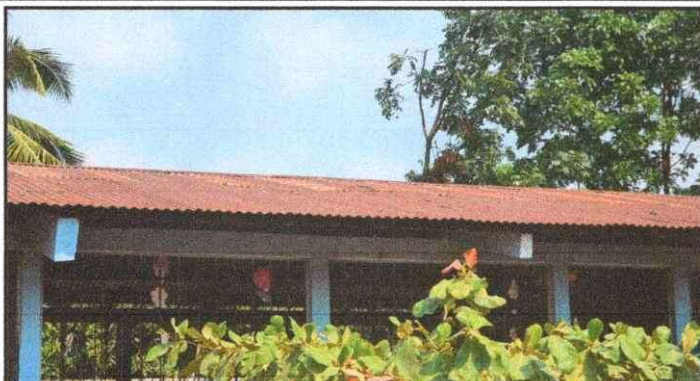
Foto1: Se observa el deterioro de las laminas portantes del modulo 1
