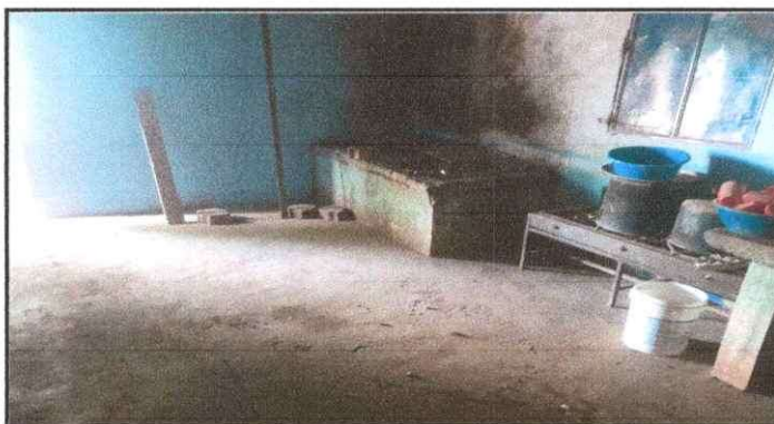
Foto 4: Se observa el modulo del piso de la cocina
