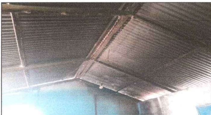
Foto 3: Se observa la estructura portante del modulo de la cocina.
