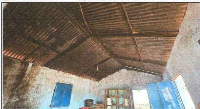
Foto 2: Se observa el deterioro de las laminas portantes del modulo 2
